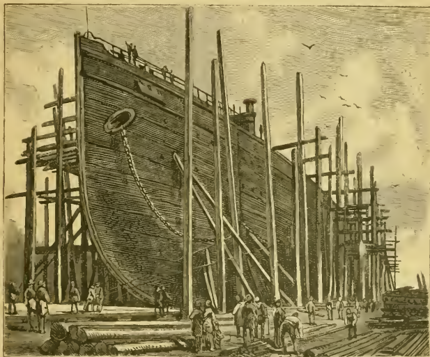
FIG. 113. — CONSTRUCTION D'UN navire porte-train.
